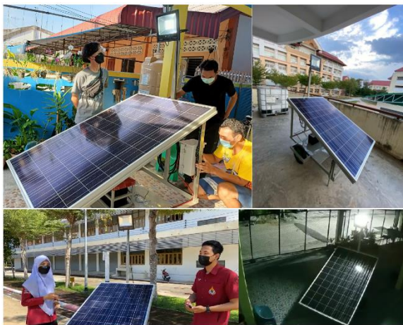
Figure 2 การติดตั้งและทดสอบโคมฉายแบบเคลื่อนที่พลังงานแสงอาทิตย์
